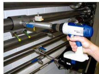
**Bild 6 Anbohren unter Druck**
