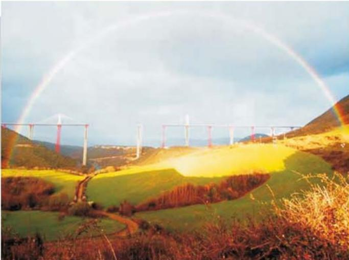
Die technischen Anforderungen für eine grazile Brücke an dieser windexponierten Stelle waren enorm. 2.460 Meter beträgt die Gesamtlänge der Brücke. Der größte Pylon, der auch gleichzeitig der höchste Autobahnbrückenpfeiler der Welt ist, hat eine Höhe von 343 Metern und ist damit 19 Meter höher als der Eiffelturm.
